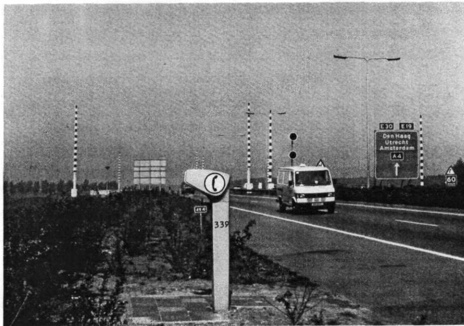
praatpaal is goed bereikbaar
